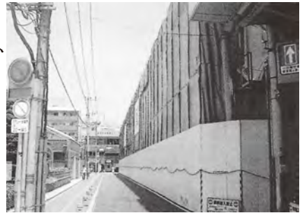
工事中のセントポルタビル
