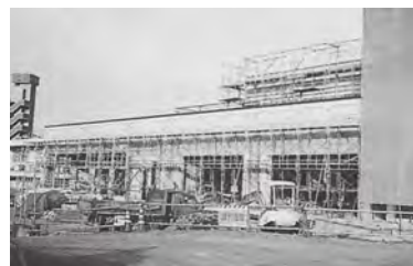
建設進む西部共同調理場
