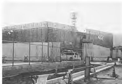
大南支所建て替え工事
