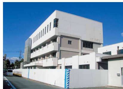
工事中の旧社会福祉センター
