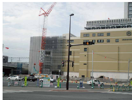
駅ビル東側の交通結節機能施設予定地
