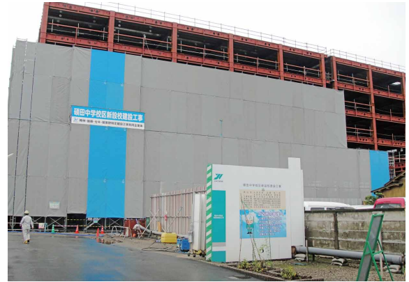
工事中の新設校
