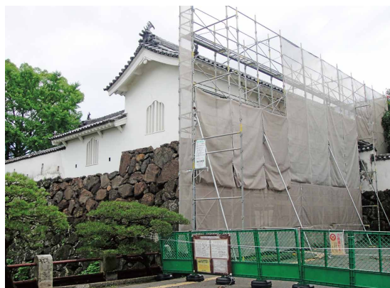
大手門屋根瓦の復旧
