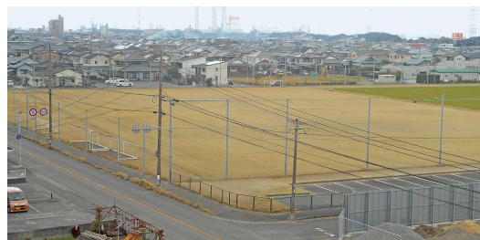
大在東小・建設予定地
