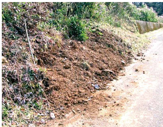
イノシシに掘り起こされた道路わき
