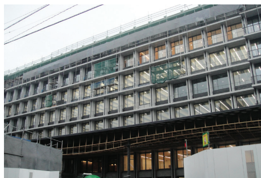
建設中の荷揚複合公共施設
